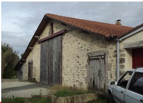
Grange, La Noue du Bourg
