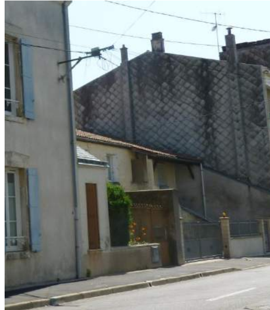
Ardoise d'amiante ciment
