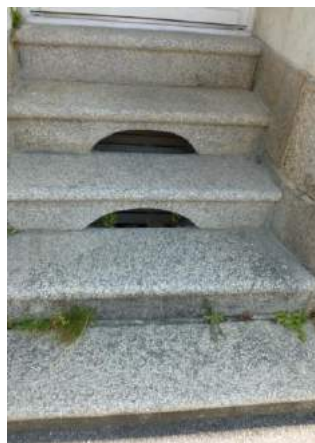
Portes et aérations de cave – un espace aéré permettant isolation et salubrité
