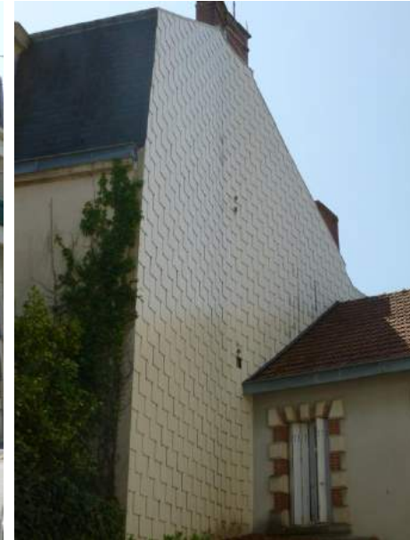
Ardoise fibres ciment (ciment et fibres minérales).
