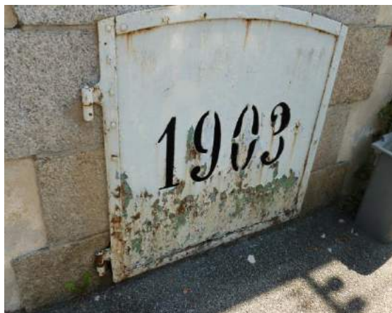
Portes et aérations de cave – un espace aéré permettant isolation et salubrité
