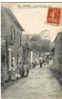
Rue d'Ecquebouille A.D. cote 2Fi804
