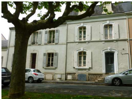
166 et 168 boulevard Aristide Briand
