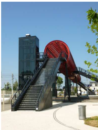
La nouvelle passerelle
