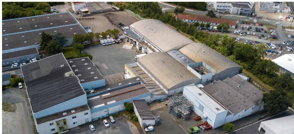
Bâtiment Sofrica réhabilité dans le cadre du projet
