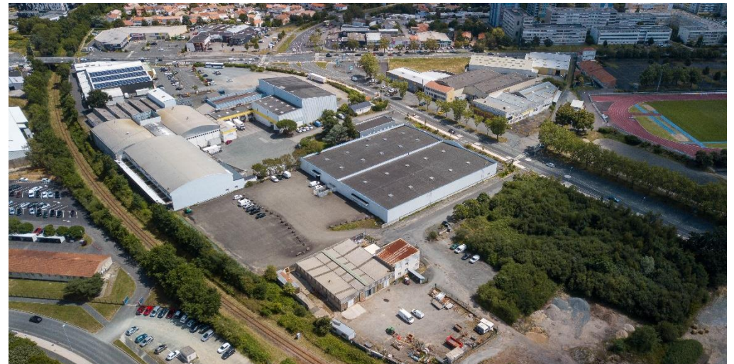
Vers une attention spécifique à la gestion des eaux pluviales
