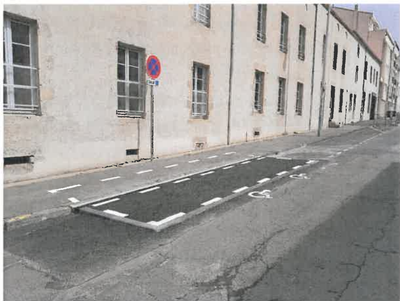
Rue de la Marne, dans le cadre de l'inclusion scolaire, avec le terrassement, la pose de bordures, la mise en place des enrobés, la pose de grilles caniveau, le marquage au sol, l'implantation des panneaux pour un coût de 6243.49 €
