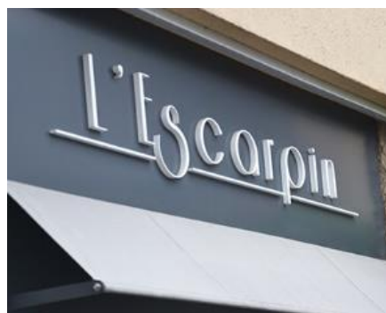
Enseigne en relief centrée dans un bandeau positionné dans l'épaisseur du mur. Le bandeau intègre le mécanisme du store banne
