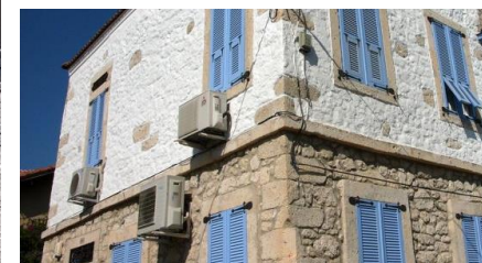
Mauvaise intégration des éléments techniques
