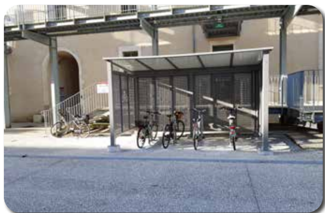
Abri vélo ouvert 8 places implanté au CYEL
