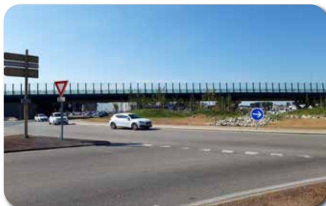
Giratoire Palissy (RD 160), point accidentogène pour les cyclistes
