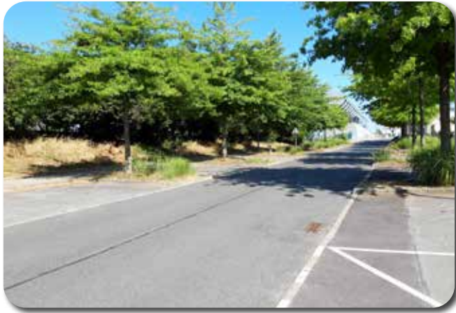
Rue de Réaumur
